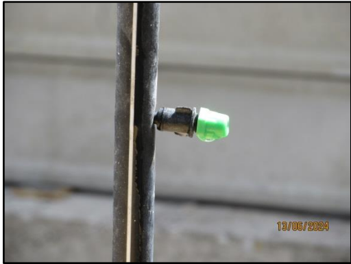
รูปที่ 10 (ต่อ) ติดตั้งระบบสเปรย์น้ำรอบบริเวณพื้นที่ก่อสร้าง
