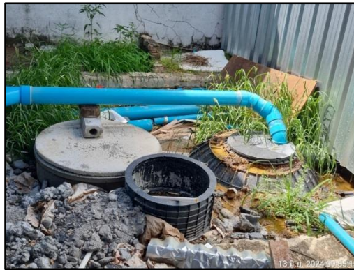
รูปที่ 49 ถังบำบัดน้ำเสียสำเร็จรูป บริเวณพื้นที่ก่อสร้างโครงการ
