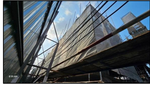
รูปที่ 86 วัสดุกันเศษวัสดุร่วงหล่นขณะทำโครงสร้าง
