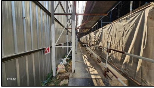
รูปที่ 86 วัสดุกันเศษวัสดุร่วงหล่นขณะทำโครงสร้าง
