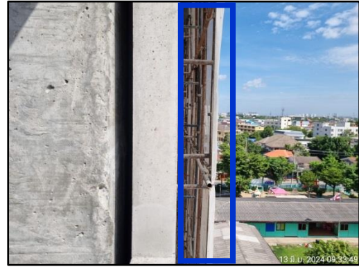
รูปที่ 32 (ต่อ) ติดตั้งผ้าใบก่อสร้าง Mesh Sheet ตั้งแต่ชั้นล่างจนถึงชั้นสูงสุดของอาคารโครงการ ด้านที่ติดกับโรงเรียนอนุบาลดวงจิต (ทิศเหนือ)
