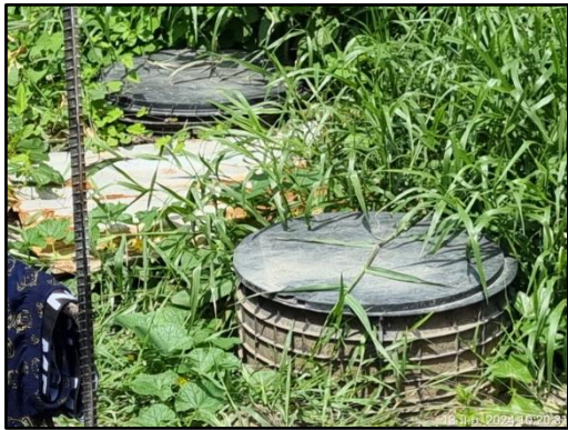
รูปที่ 50 ถังบำบัดน้ำเสียสำเร็จรูป บริเวณบ้านพักคนงาน
