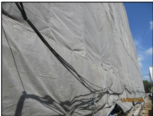
รูปที่ 8 ผ้าใบกันฝุ่น (Mesh Sheet) รอบอาคาร
