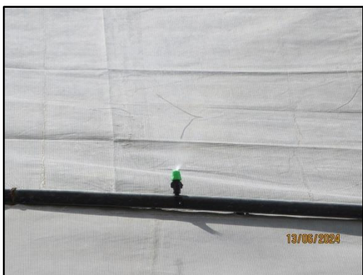
รูปที่ 10 ติดตั้งระบบสปริงค์น้ำรอบบริเวณพื้นที่ก่อสร้าง
