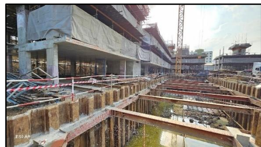
รูปที่ 43 ผนังกันดิน แบบ Sheet Pile
