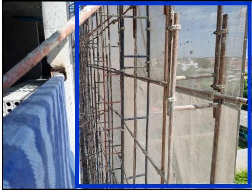
รูปที่ 32 (ต่อ) ติดตั้งผ้าใบก่อสร้าง Mesh Sheet ตั้งแต่ชั้นล่างจนถึงชั้นสูงสุดของอาคารโครงการ ด้านที่ติดกับโรงเรียนอนุบาลดวงจิต (ทิศเหนือ)
