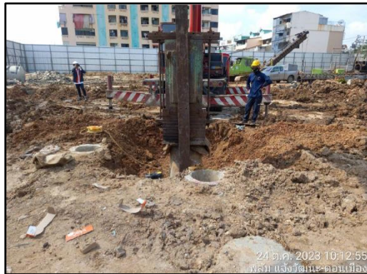
รูปที่ 41 (ต่อ) การทดสอบการรับน้ำหนักของเสาเข็ม (Dynamic Load Test) และการติดตั้งเสาเข็ม
