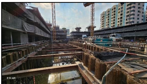
รูปที่ 43 ผนังกันดิน แบบ Sheet Pile
