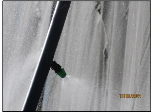
รูปที่ 10 (ต่อ) ติดตั้งระบบสเปรย์น้ำรอบบริเวณพื้นที่ก่อสร้าง
