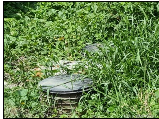
รูปที่ 50 ถังบำบัดน้ำเสียสำเร็จรูป บริเวณบ้านพักคนงาน
