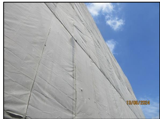
รูปที่ 8 ผ้าใบกันฝุ่น (Mesh Sheet) รอบอาคาร
